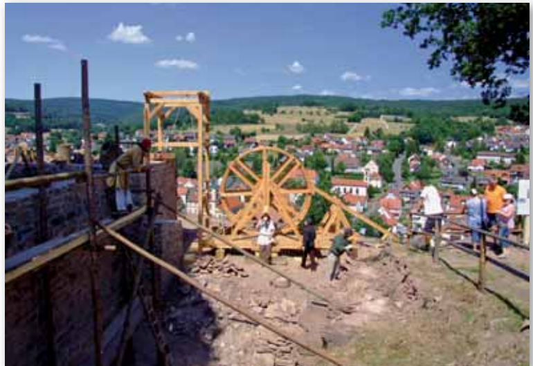
Abb. 1: Rekonstruierter mittelalterliche Baukran an der Burg Bartenstein bei Partenstein. Die Burg wurde mit großem Engagement der Bürger von Partenstein archäologisch untersucht und teilweise rekonstruiert. Auch der Nachbau eines mittelalterlichen Krans wurde von freiwilligen Helfern in einer örtlichen Schreinerwerkstatt gebaut. Inzwischen steht er seit sechs Jahren auf der Burg – ohne irgendwelche Beschädigungen. Nur die Farbe ist inzwischen nicht mehr gelb, sondern grau.
